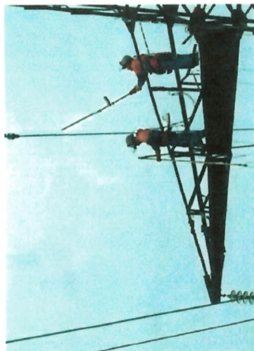
Рис.1 Пример измерения наведенного напряжения на проводе ВЛ 110кВ.
